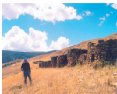
19.- Depósitos para preservar el excedente de la cosecha de alimentos en general, construido a base de lajas de piedras con ventilación permanente natural. Centro arqueológico Garu/alto Marañón. Provincia de yariwilka choras/Huánuco
