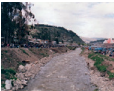
7.-Canal de encause del río chumbau. En ambos bandos se observa la feria dominical.
